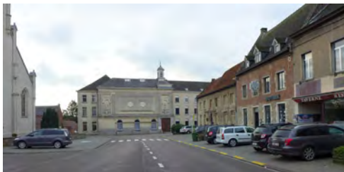
pleinwand Dorpsplein vandaag
